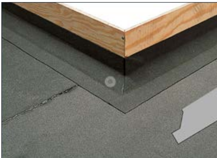
Figur 3.3.b: Udadgående hjørne. Anden understrimmel vist som principskitse.
